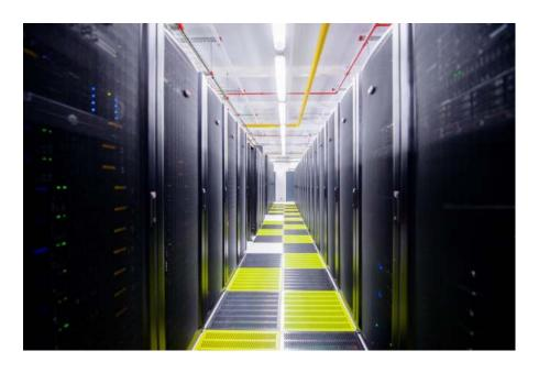
Машинный зал ЦОД ПРОВЕРКАСТ расположен в бывшем бомбоубежище в специально сконструированной гермозоне, обеспечивающей надежную защиту оборудования от негативных внешних воздействий. Для размещения оборудования применяются серверные шкафы размером 42U, 600X1000мм Cabeus. Применяемые технологические решения обеспечивают организацию "холодного коридора" для эффективного охлаждения серверного и телекоммуникационного оборудования.
